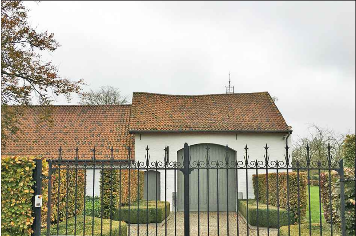
Het poortgebouw van het Personaatshof, anno 2024.
